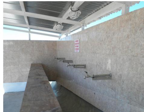
**Sector para limpieza de pescado:** Finalizaron las tareas destinadas a brindar más comodidades a los socios que practican la pesca. Incluye techo, recubrimiento de cerámica, nueva mesada y canalón de fibra de vidrio, instalación de agua embutida con grifería y soportes de acero inoxidable, iluminación, tablero eléctrico, etc.
