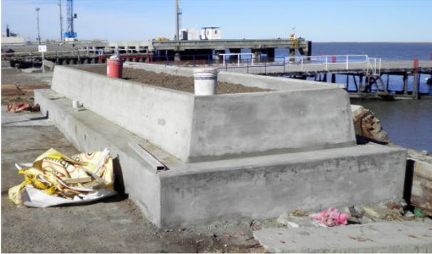
Se está terminando el cantero construido sobre losa de hormigón existente. Ya se lo rellenó con tierra negra y la próxima semana se colocarán plantas y se pintará.
