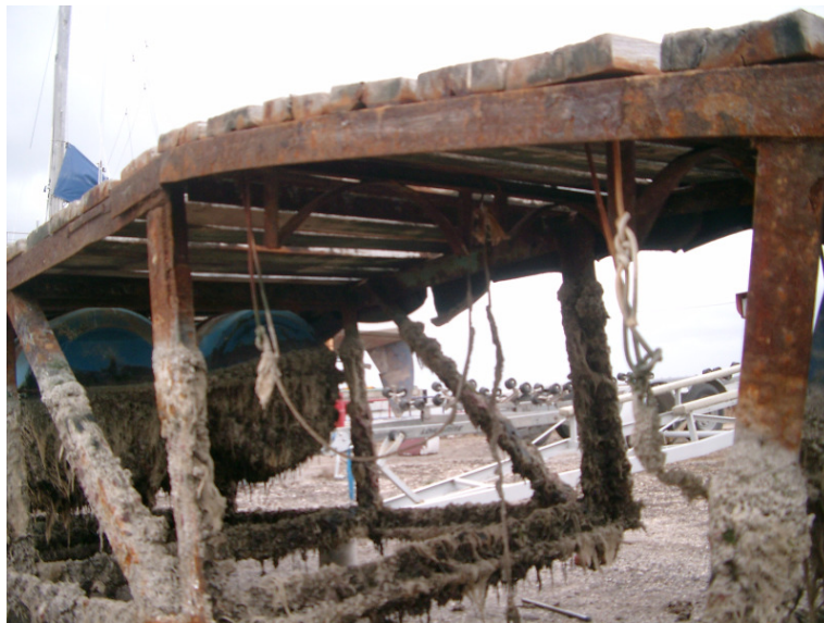
Planchada de 12 m. del pontón
