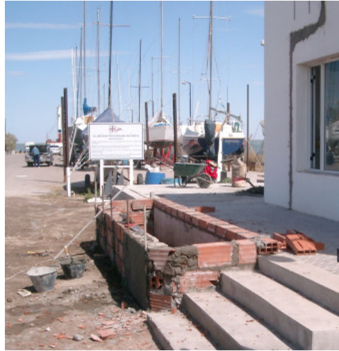
Se está construyendo un nuevo cantero
